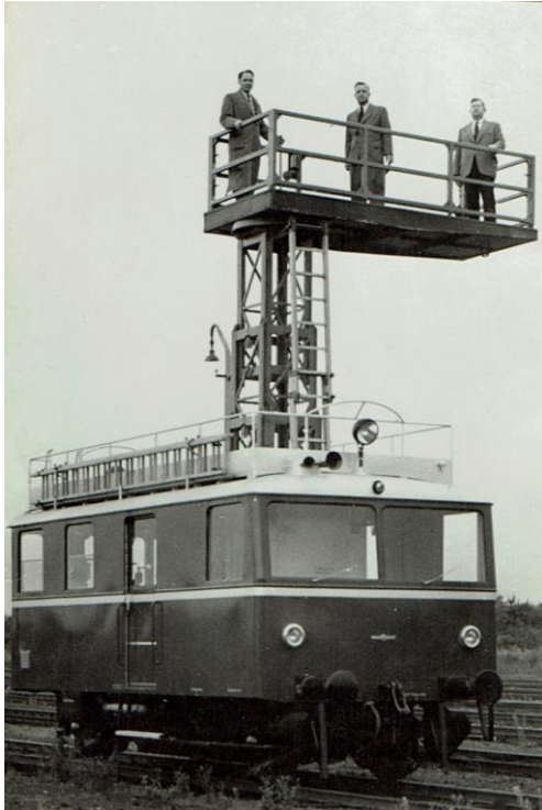
Turmdraisine bei der Abnahme
