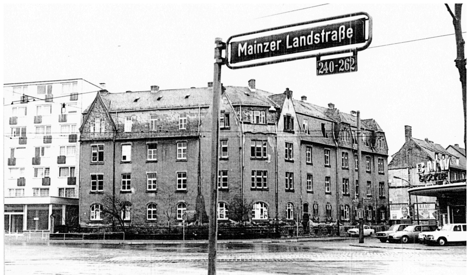
Wohnblock des „Fiskus Eisenbahn“ an der Galluswarte 1975, bald darauf abgerissen. Heute steht dort das Ärztehaus. (© ISG Renate Ullrich)
