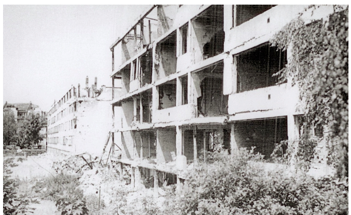
Zerstörte Hauszeilen des ersten Bauabschnitts, Cordierstraße 41-49 und 28-40. Der Verlauf der Risse und Abbrüche deutet auf die Bauweise mit Bimsbetonplatten hin. © ISG S7ko 1672, Fred Kochmann
