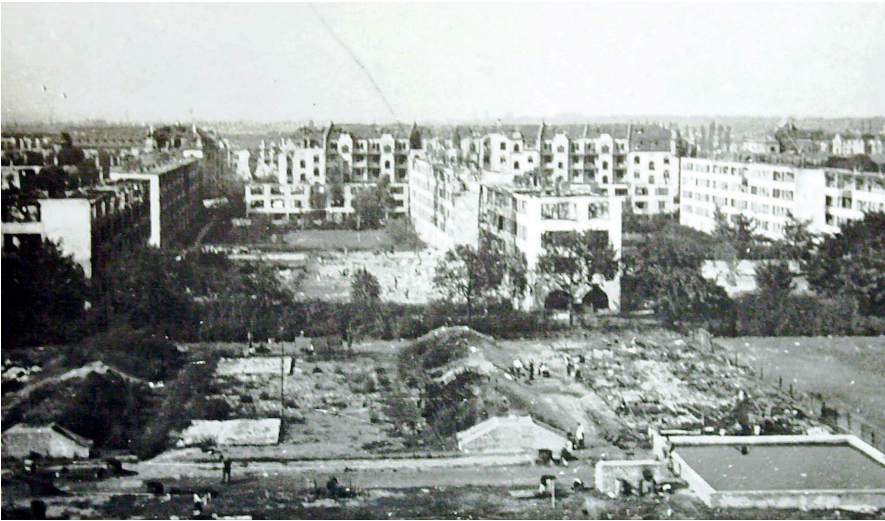
Blick vom Bunkerdach über die Luftschutzdeckungsgräben des Zwangsarbeiterlagers und den Löschwasserteich auf der Ackermannwiese zu den zerstörten Bauten an der Cordierstraße und Mainzer Landstraße. In dem Lager waren französische, belgische und holländische Kriegsgefangene untergebracht, die bei Teves unter lebensgefährlichen Bedingungen produzieren mussten. Foto: H.P. Schmidt
