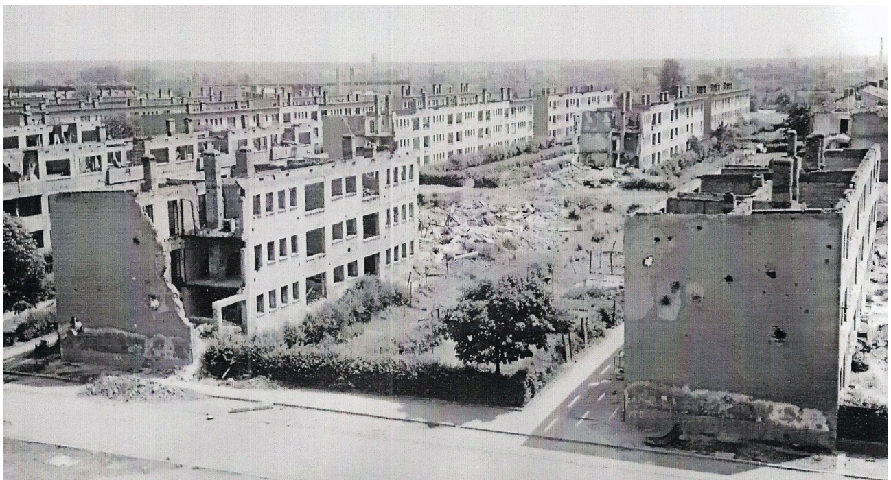
Das blieb: Zum Kriegsende waren die meisten Gebäude zerstört, hier ein Blick (1947) vom Bunker aus über die Tevesstraße Richtung Süden in den zweiten und dritten Bauabschnitt. Die Trümmer wurden bereits abtransportiert. © ISG S7Ko 1673, Fred Kochmann
