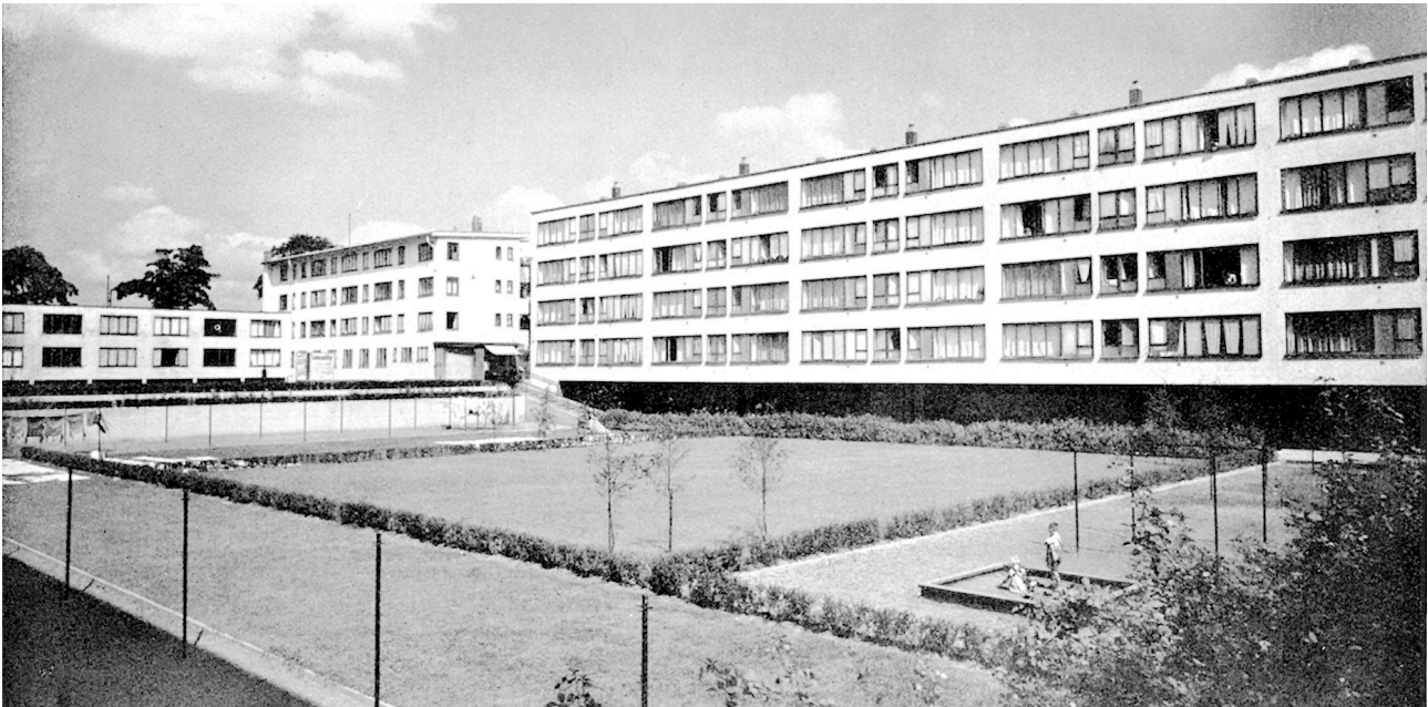
Blick in einen der Gartenstreifen kurz nach der Fertigstellung 1930. Im Hintergrund die erhöht liegende Sonnenberger Straße, heute Cordierstraße, dahinter die Rückseite der an der Mainzer Landstraße gelegenen Kopfbauten © Aktiengesellschaft für kleine Wohnungen
