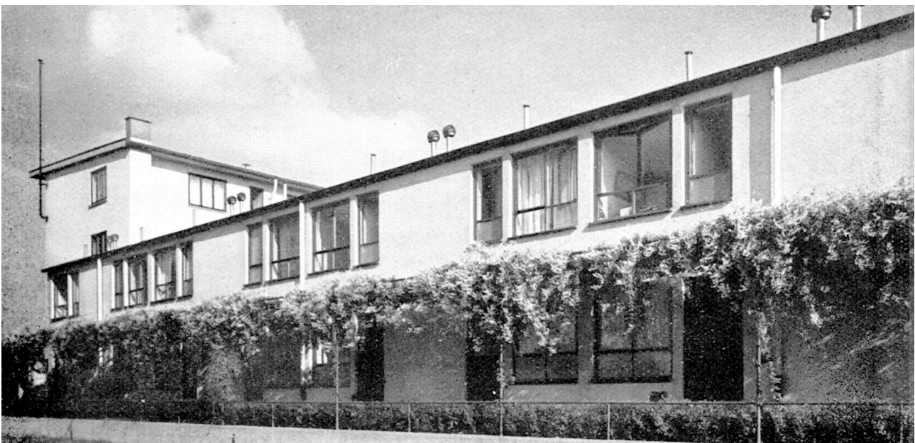
Die Kopfbauten des ersten Bauabschnitts an der Mainzer Landstraße wurden als Einfamilienhäuser ausgeführt. Da das rückwärtige Gelände tiefer liegt, verfügen sie über ein weiteres, dort ebenerdiges Sockelgeschoss. Dieses Foto ist vermutlich 1932 entstanden © Aktiengesellschaft für kleine Wohnungen
