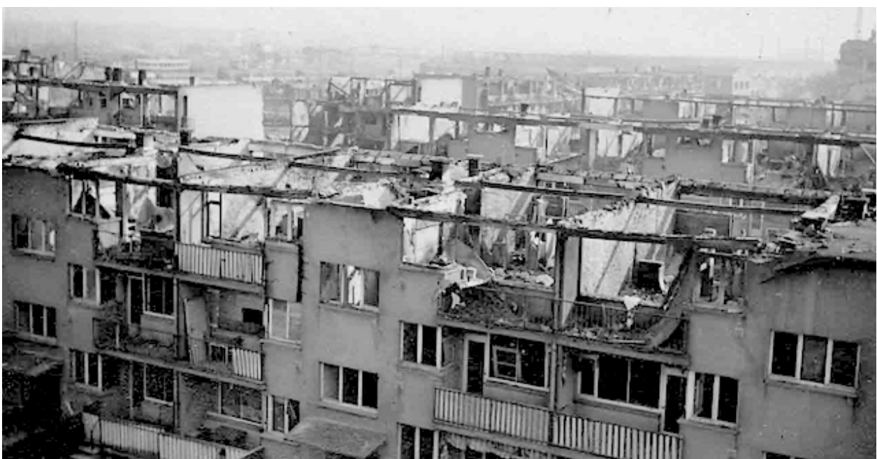
Beschädigte Zeilenbauten; Blick von der Kelkheimer Straße nach Osten, ca. 1945, Foto: privat
