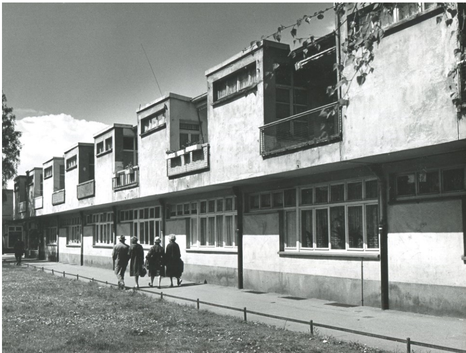
Das Bild zeigt die Kopfbauten an der Frankenallee um 1960, als die Kriegsschäden, die es auch hier gegeben hatte, bereits ausgebessert waren. 1
